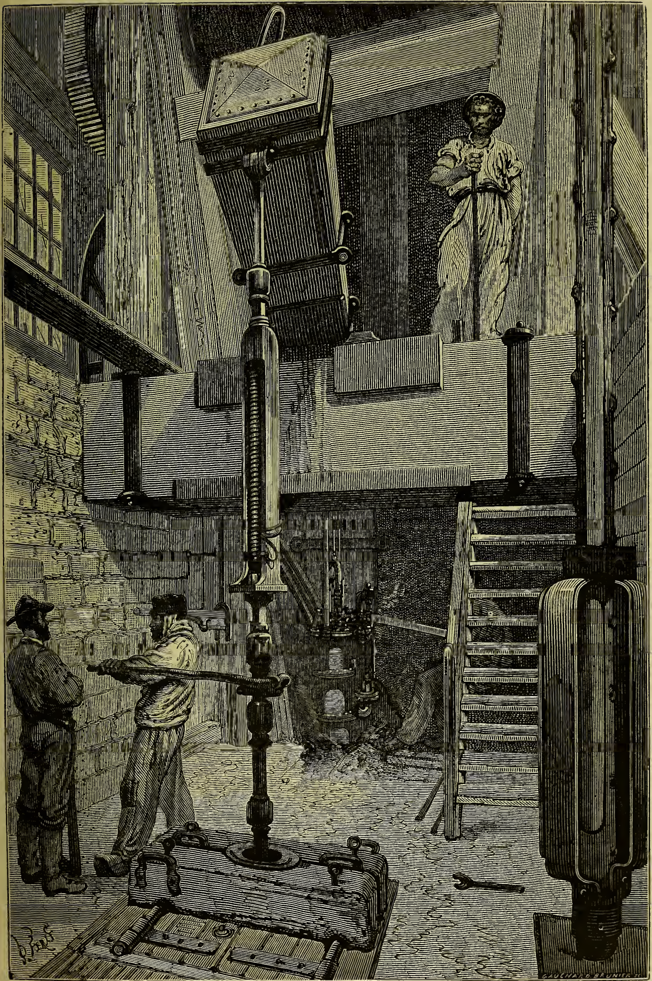
Fig. 24. — Installation d'un sondage (système Mulet et Saint-Just-Dru). Forage du trou.
